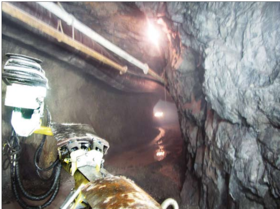
«Boomer» уходит в недра. Его работа – бурить штольню.
