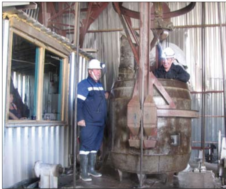
Заместители технического директора компании-застройщика Анатолий Андросов и Владимир Созонов и сами нередко inspectуют работы в вентиляционном стволе.
