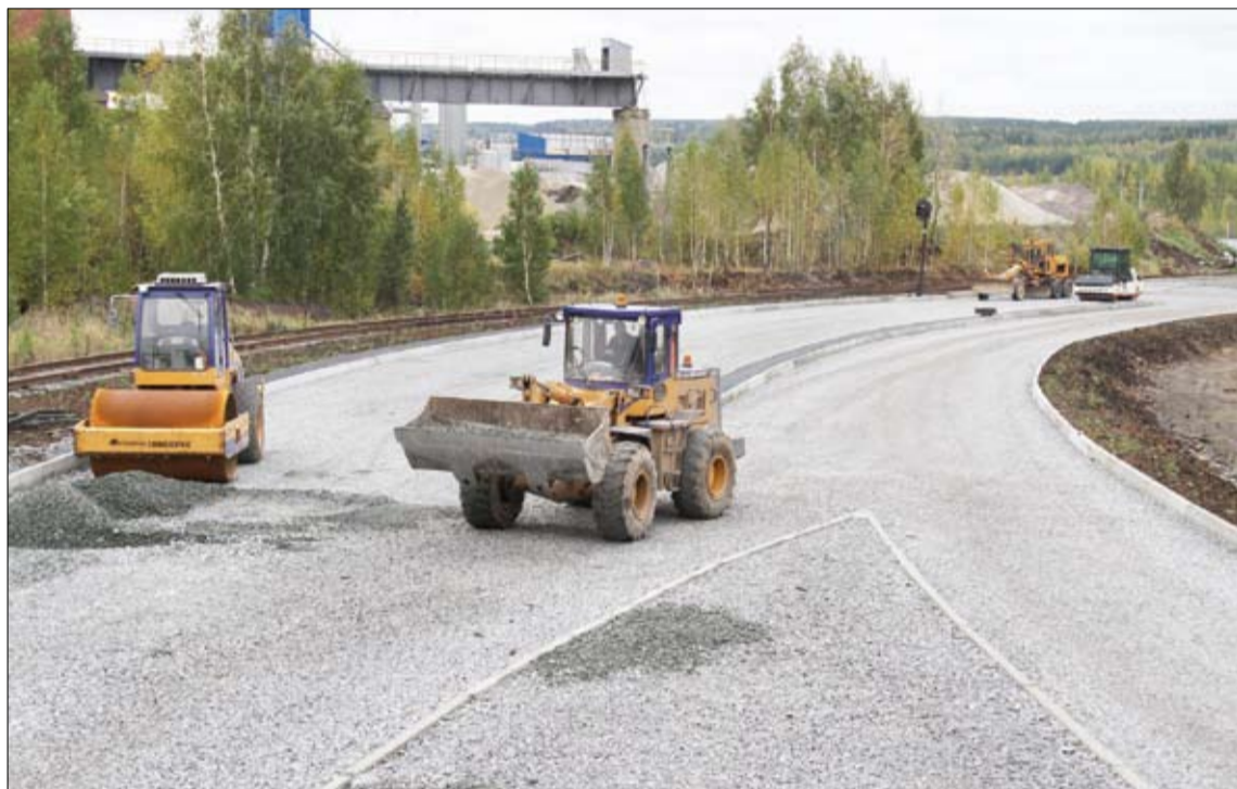
Работа кипит: объездная дорога – объект большой важности.
