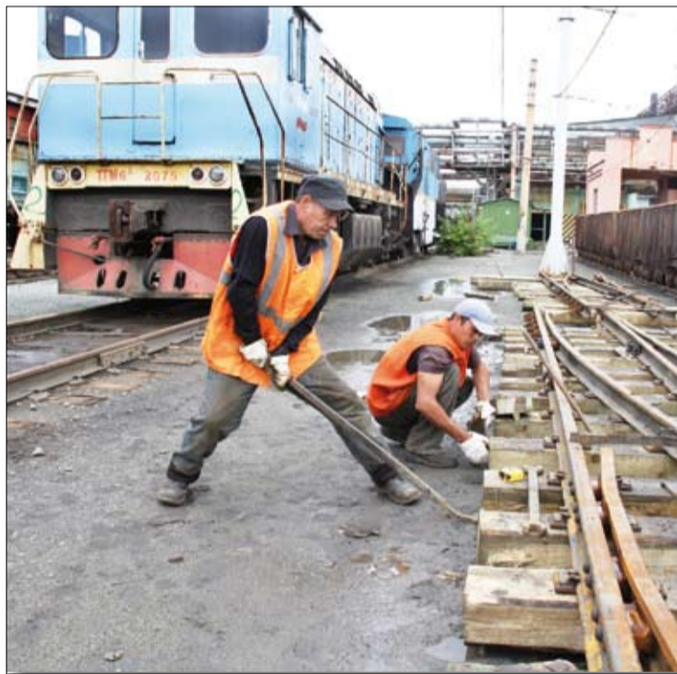
Монтеры пути собирают новый стрелочный перевод узкой колеи.
