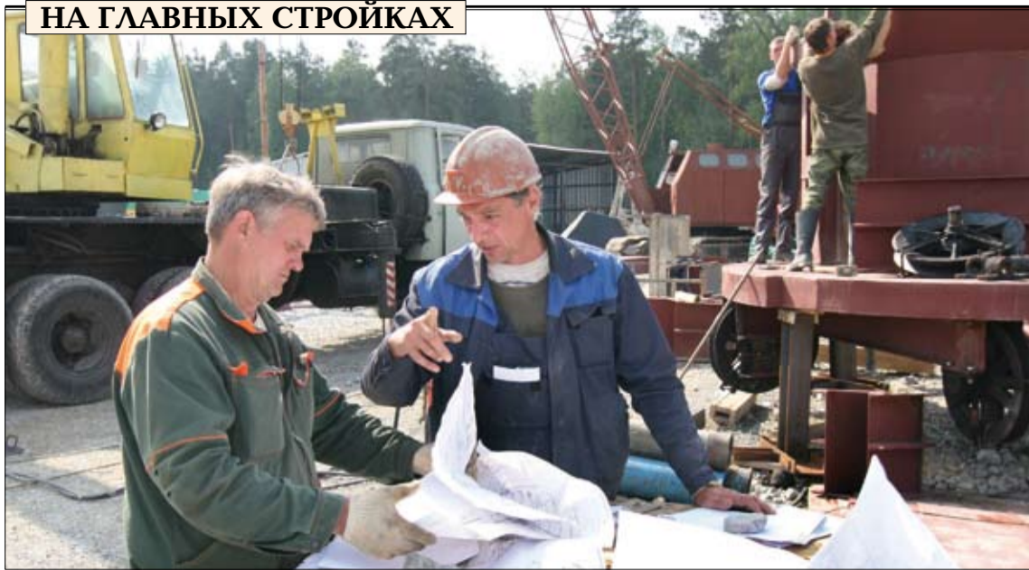
Сегодня на будущем подземном руднике главные — проходчики.
